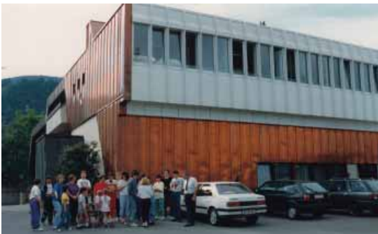
Ein Stockwerk für vier Schulklassen kommt dazu.
